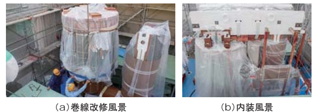
図18 巻線の現地改修風景
