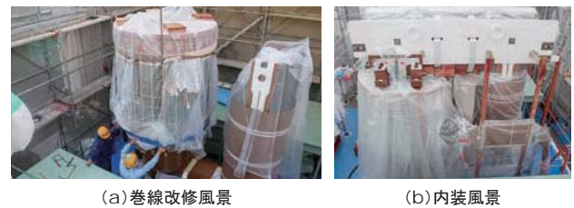
図18 巻線の現地改修風景
