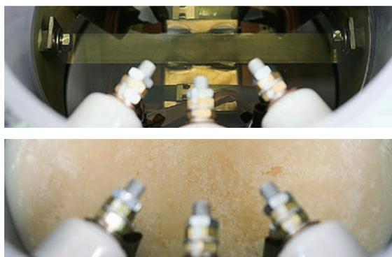
図5 油凝固前(上)、油凝固状態(下)の変圧器内部
