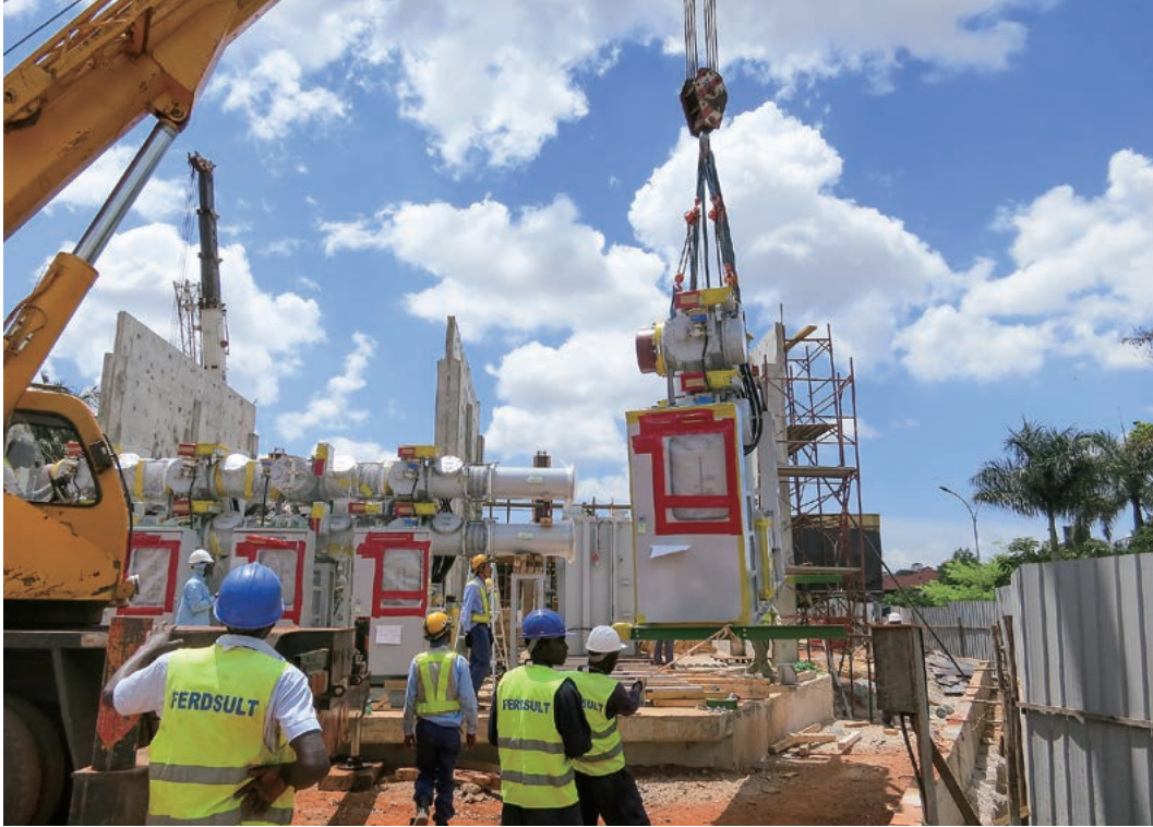
132 kV GIS の据付作業風景
