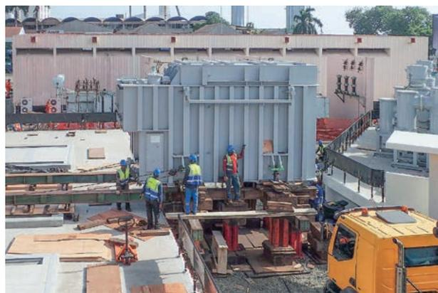
図4 主変圧器 据付作業
