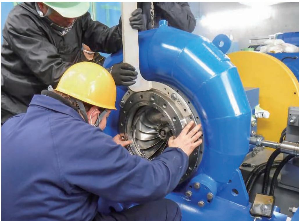
発電設備の設置作業風景
