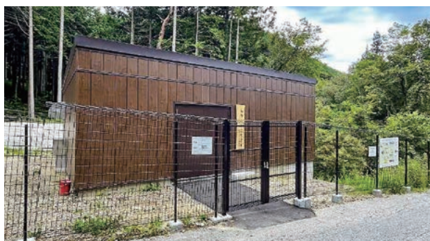
図1 野底川小水力発電所外観
