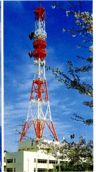
■中部電力浜岡原子発電所 通信用無線塔
