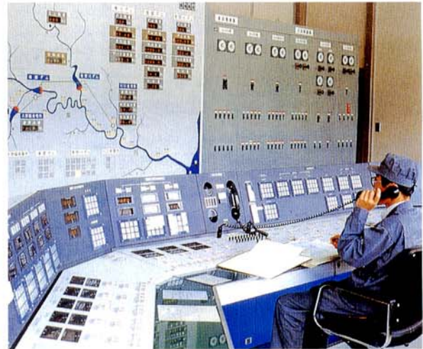
■ダム管理設備工事
