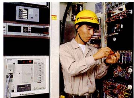
■計算機システム設備工事
