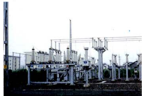
■変電所設計施工
